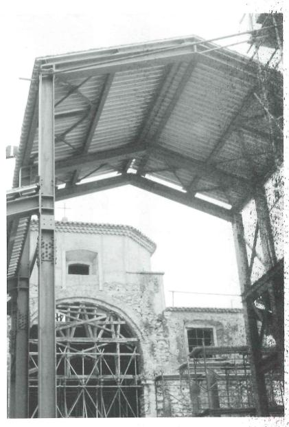
Rimontaggio dei basamenti lapidei e preparazione della ricostruzione in muratura delle colonne
